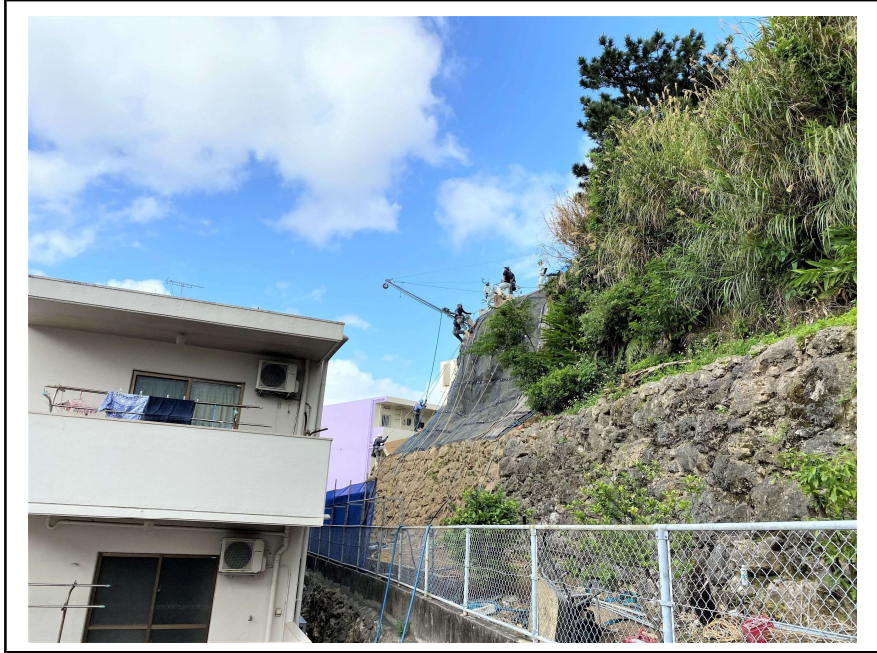
ソイルネイル打設状況
