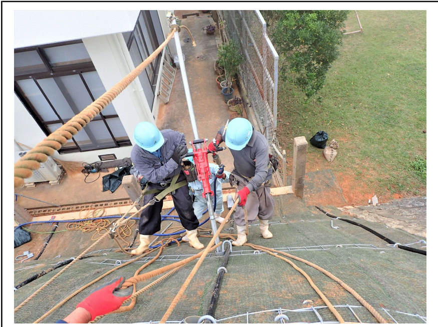
ソイルネイル打設状況
